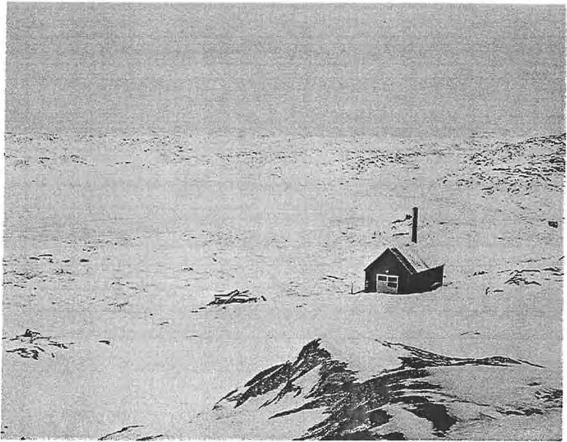
Forbrændingsanlægget i Attu
