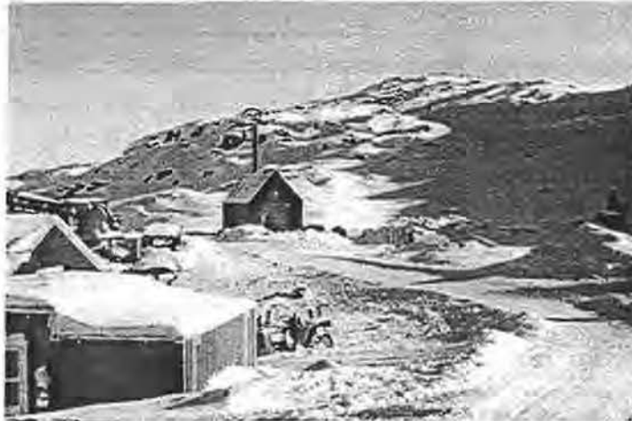
fig. 1 - Forbrændingsanlægget i Kangaatsiaq
