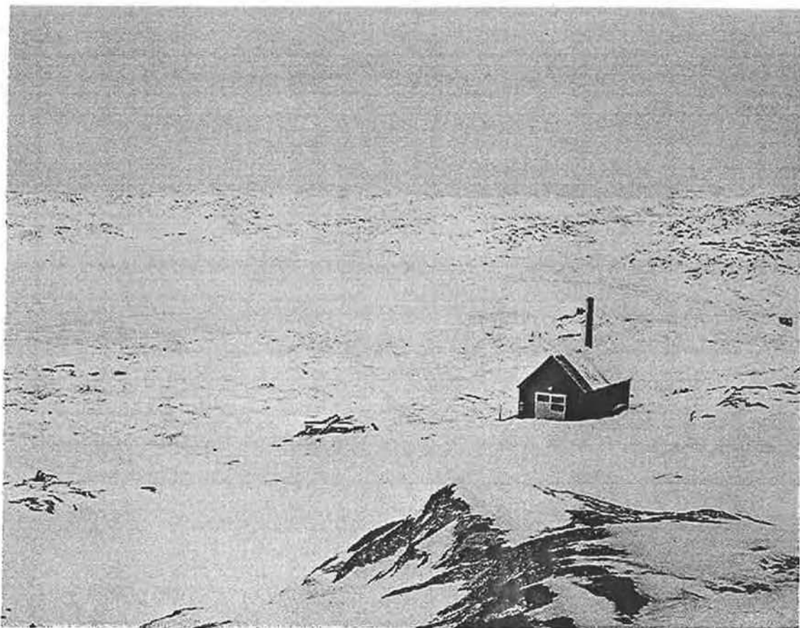
Forbrændingsanlægget i Attu
